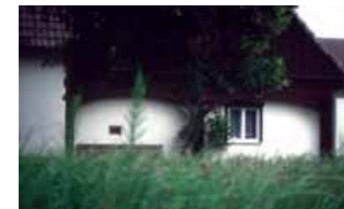
Kommt man von Westen nach Lindena fällt ein renoviertes giebelständiges Haus mit zwei gleichgroßen Jochen (Umgebindehaus) von 1750 auf. Bei dieser Bauweise wird das Dachgerüst nicht von dem eigentlichen Unterbau, sondern von vorgesetzten Ständern
