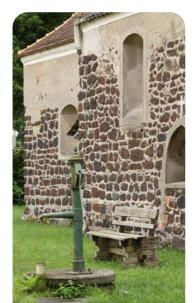
Raseneisenstein wurde im Mittelalter häufig beim Bau von Ecken und zum passgerechten Schließen von Mauern eingesetzt. Das Gestein ist ein Gemenge aus Sand, Ton oder Schluff und Eisenoxid. Er entsteht dort, wo eisenhaltiges Grundwasser den Boden nahe der Oberfläche durchströmt.
