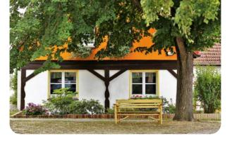
In Lindena fällt ein giebelständiges Haus mit zwei gleichgroßen Jochen (Umgebindehaus) auf. Bei diesem besonderen Haustyp wird das Dach nicht von dem eigentlichen Unterbau, sondern von einem vorgesetzten hölzernen Stützensystem getragen.
